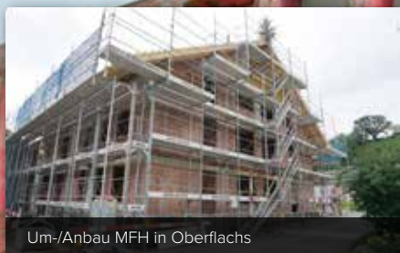
Fassadenbau mit EPS-Isolation
