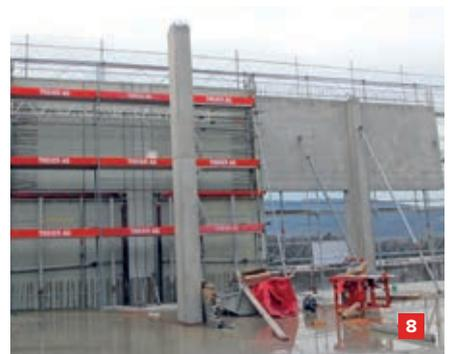
8 Für Schalungsarbeit sind Grossflächeneinheiten für die hohen Wände und spezielle Säulenschalungselemente mit Flügeln im Einsatz
